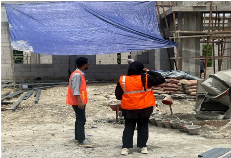
Gambar 4. Persiapan pendampingan pencampuran beton normal
